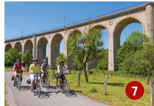
Grote viaduct De 482 meter lange 'Grote Viaduct', de grootste stenen spoorwegbrug van Europa, overkoepelt met 24 bogen het Bekedal.
